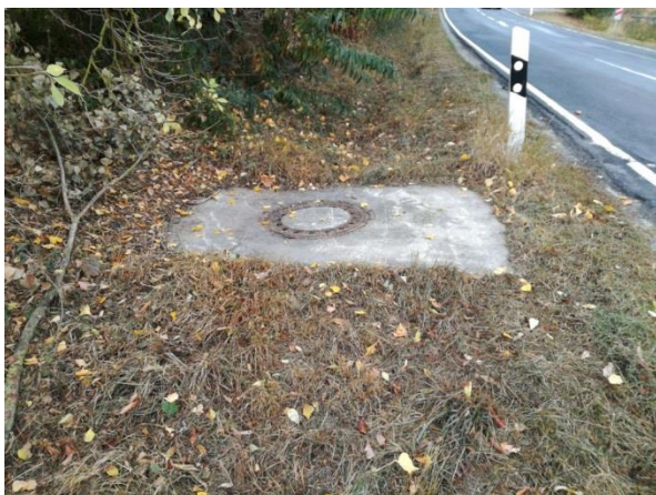
Q19_Schacht neben Straße oberhalb Eselsbrunnlein
