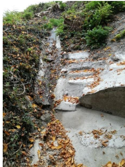
Q17 betonierte Rinne unterhalb Eselsbrunnlein
